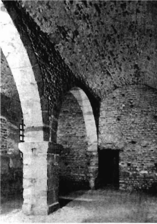
Erdgeschoß des Ostturmes mit Substruktionswand der Zelle, darin die Öffnung als Zutritt zu der dahinter befindlichen Säule. Bogenkonstruktion und Gewölbe um 1035/40 für den darüber gebildeten Vorraum der Zelle.
