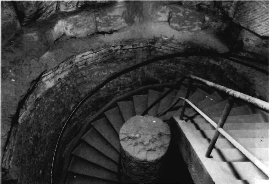
Blick auf die Säule mit der Wendeltreppe, noch mit dem alten Abschluß, und die Ansätze der Ringtonne als Substruktion (nach 1035/40) der Zelle Simeons.
